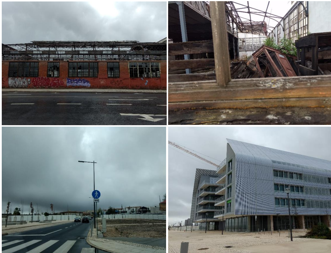
Imagem 5, 6, 7 e 8 - Marvila Ribeirinha – galpão abandonado e construção do Prata Living Concept. Fonte: Arquivo pessoal.
